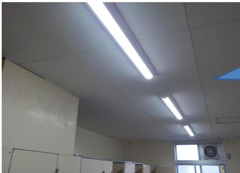
トイレのLED照明を手動スイッチから人感センサーに交換した。その結果、消し忘れが無くなり、節電効果がみられる。
