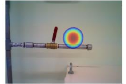
図2 エア漏れ検出画像
