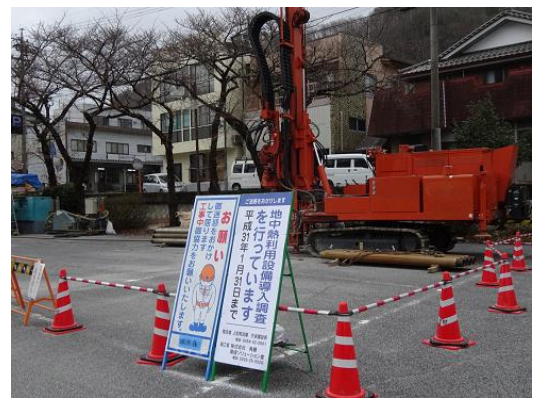
【現地調査箇所】
