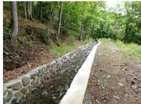
【工事が完了した大河原堰（茅野市）】
