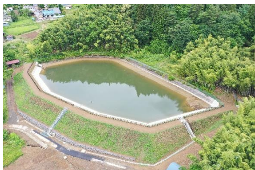
【防災重点農業用ため池の耐震化】 （上田市：山田新池）
