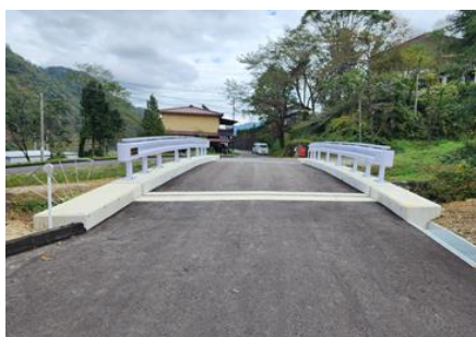
【集落道（橋梁）の整備（上田市）】
