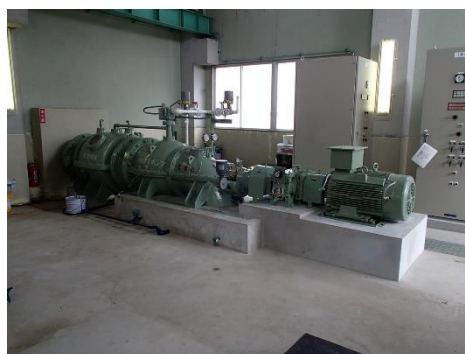
【排水機場の改修（排水ポンプ）】 （長野市：前川排水機場）
