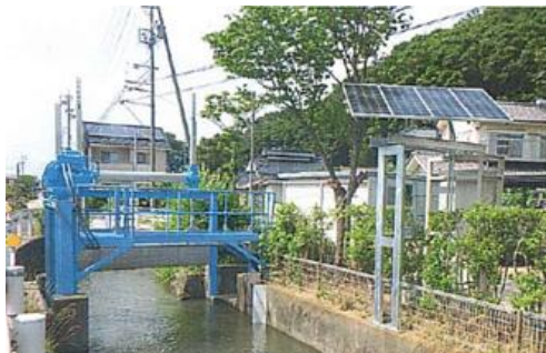
【自動化した会地排水門（坂城町）】
