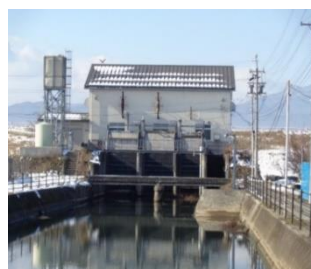
【須坂市 福島地区 福島北排水機場】
