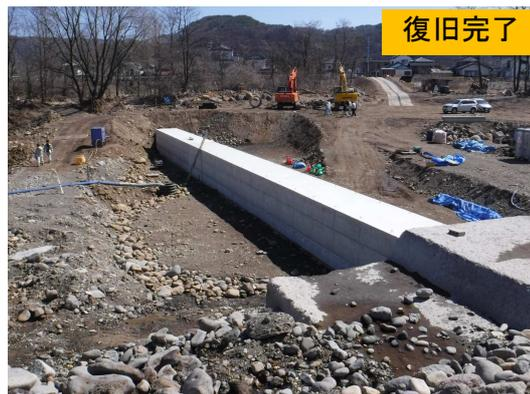
【損壊した水路（サイホン）を撤去し、新しい管を設置】
