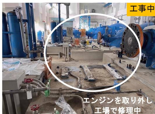
【浸水した排水ポンプを復旧（長沼排水機場）】
