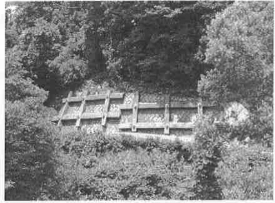
【地すべりを防止するための抑止工事】 地すべり対策事業 飯山南部地区（飯山市）
