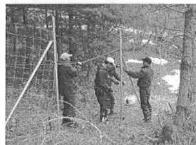
【集落住民による侵入防止柵の設置】
