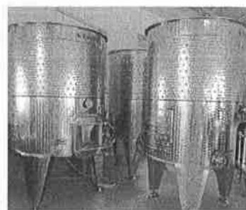
【整備された醸造施設・内部】
