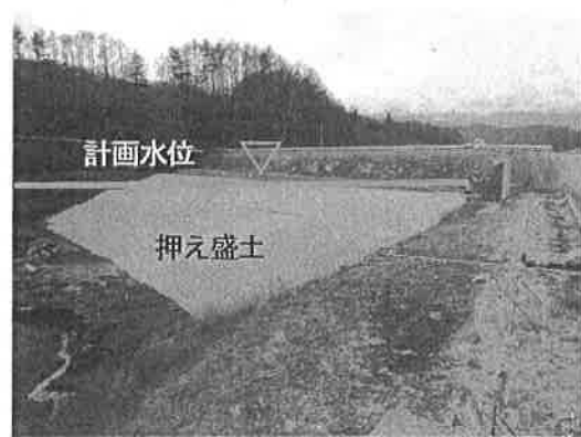
【耐震化工事が進む みどり湖（塩尻市）】
