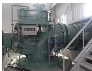
排水ポンプ能力を強化 Q=1.67\text{m}^3/\text{s} \rightarrow 4.17\text{m}^3/\text{s}
