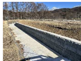
【滝之湯堰改修工事】
