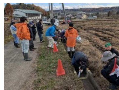
【技術研修会（水路の目地補修）】
