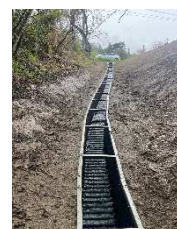
【地すべり対策 松本地区 （板場）（松本市）】
