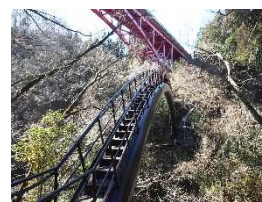
【竜東一貫水路の補修工事】
