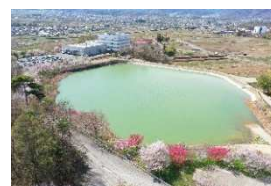
【防災工事を実施した浅間池】
