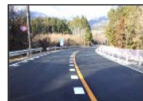
【飯島地区の農道路路面改修】
