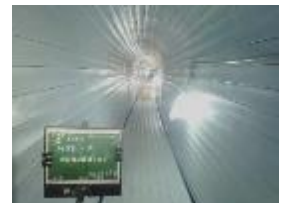
【大沼池水路トンネル】
