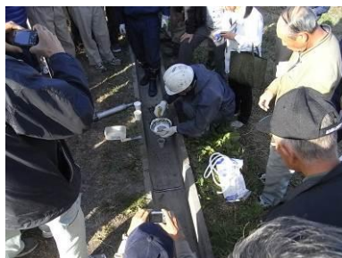
(水路目地補修)
