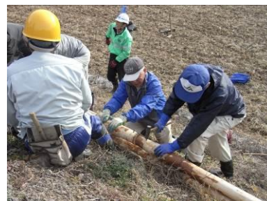
(畦畔法面への小段設置)
