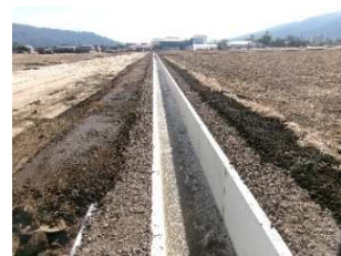
【諏訪平地区ほ場整備】
