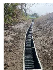
【地すべり対策 松本地区 （板場）（松本市）】
