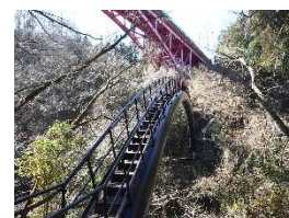
【竜東一貫水路の補修工事】
