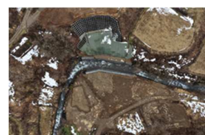
【地すべり防止工事】
