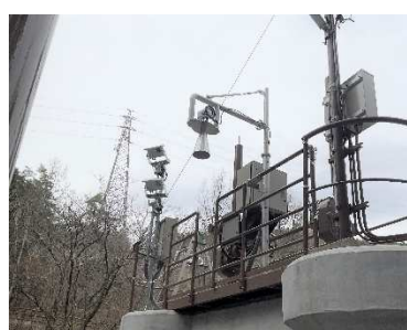
【遠隔操作が可能となった須砂渡頭首工（安曇野市）】
