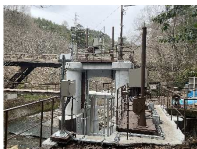
【遠隔操作が可能となった須砂渡頭首工（安曇野市）】
