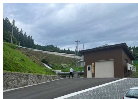
【農業用水を活用した発電施設（飯綱町）】
