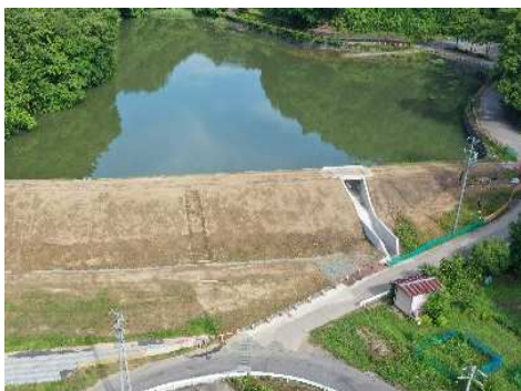
【防災重点農業用ため池の耐震化】 （上田市：幕宮池）
