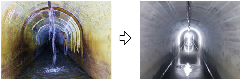
【目地部からの湧水流入状況と工事完了後の北の沢隧道（豊丘村）】
