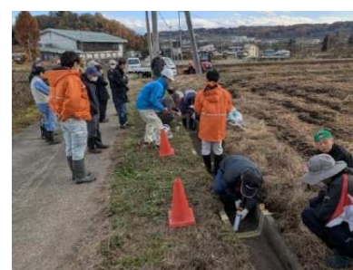
【技術研修会（水路の目地補修）】
