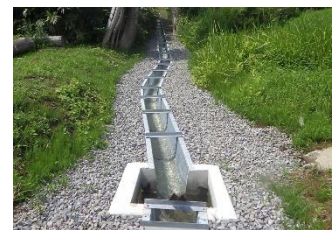
【地すべり防止工事】 （排水路工）
