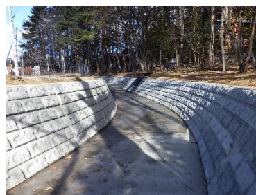
【滝之湯堰の改修工事】
