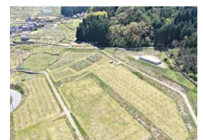
【収量・品質向上に向け樹園地に畑地かんがい施設を整備】
