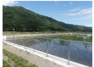
【防災工事（ため池） 本山地区（塩尻市）】
