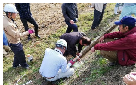
【技術研修会（水路の目地補修）】
