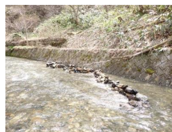
【河川内に設置した石組みの人工構造物】
