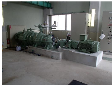
【排水機場の改修（排水ポンプ）】 （長野市：前川排水機場）
