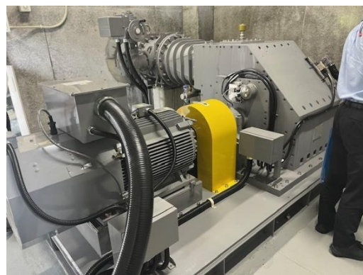
【用水を使用し発電する発電機（芋川用水発電所）】
