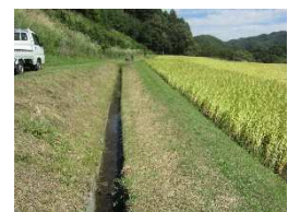
【共同活動で管理された法面・水路】
