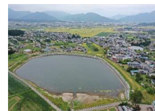
【工事済みのため池】
