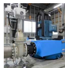
【上松町吉野発電所】
