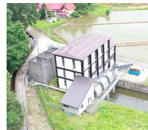
【湛水被害から農村を守る 木島第一排水機場】
