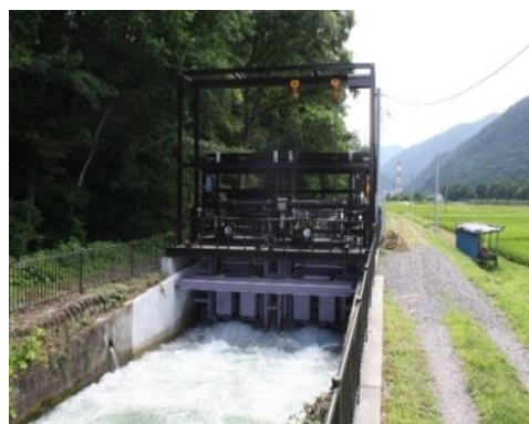
地域用水環境整備事業【梓川右岸幹線地区（松本市）】
