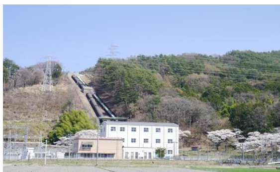
長野県企業局の春近水力発電所
