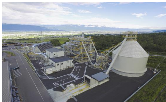
信州F・POWERプロジェクトの木質バイオマス発電所
