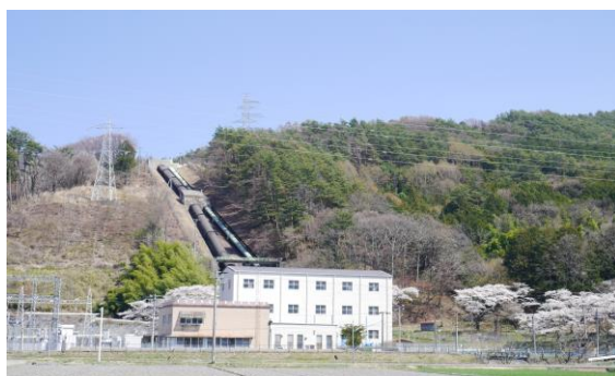
長野県企業局の春近水力発電所
