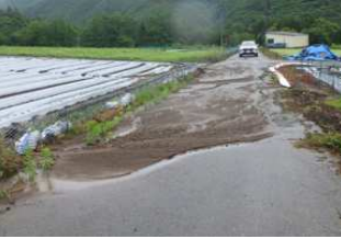
農地への越水による被害状況
