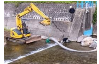
応急ポンプの設置
