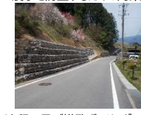
法留工及び横孔ボーリングの孔口保護の更新
