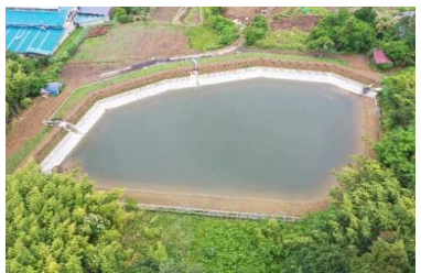
防災工事を実施した農業用ため池
