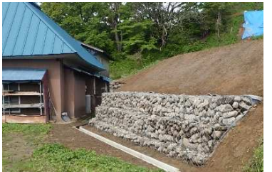
地すべり防止工事を実施した法面
