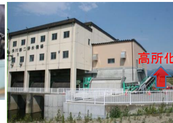
【浅川排水機場（長野市）】
