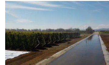
【水路兼用農道の整備】
