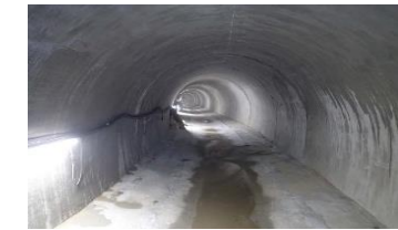
【水路トンネルの補修・補強】
