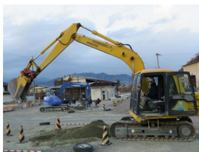
(バックホー運転技能講習)
