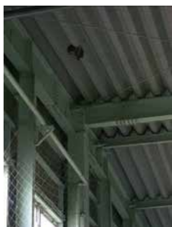
【○】防鳥ネットの設置
