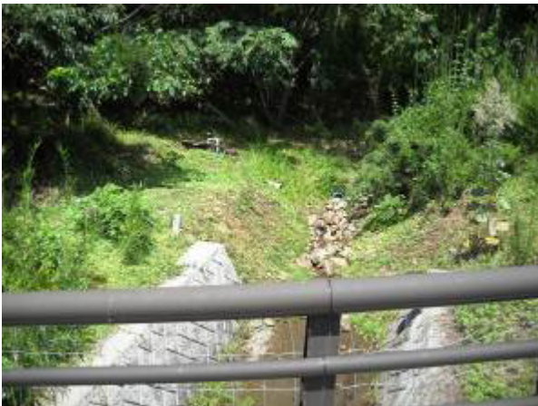
図 4 H26. 8. 29 柵外側(上流側)
