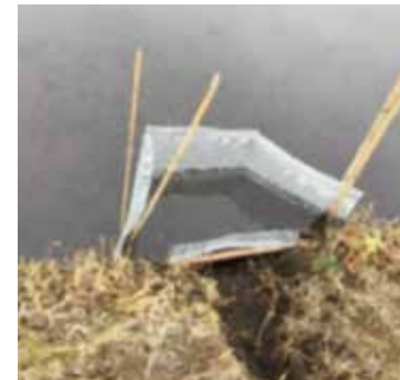
流失防止ネット設置状況 ※粗大ごみによる詰まり防止め2重に設置
