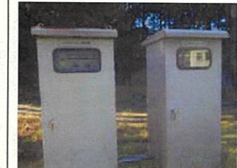
[集中制御施設]余水吐ゲート盤:更新
