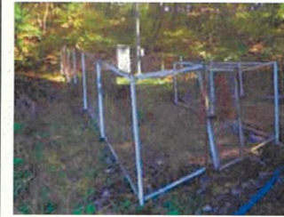
[付帯工]取水施設フェンス:更新
