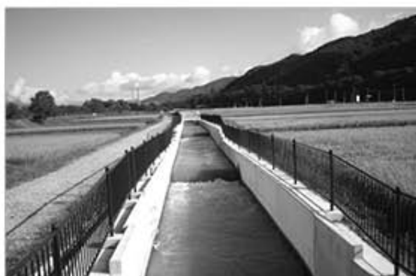
↑ 修理された水路の様子（大町市）
