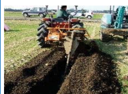
暗渠排水の整備
