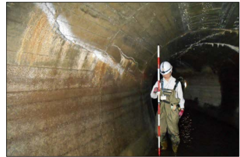
【老朽化が進む三峰川右岸幹線導水路（伊那市）】
