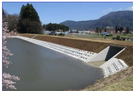
【改修が完了した深堤ため池（中川村）】
