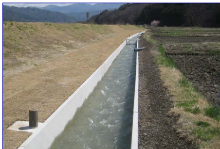
【更新整備した春富5号水路（伊那市）】
