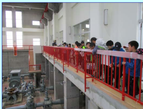
【揚水機の役割を学ぶ小学生】
