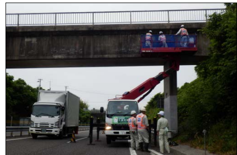
【水路橋の耐震補強のための点検作業（伊那市）】
