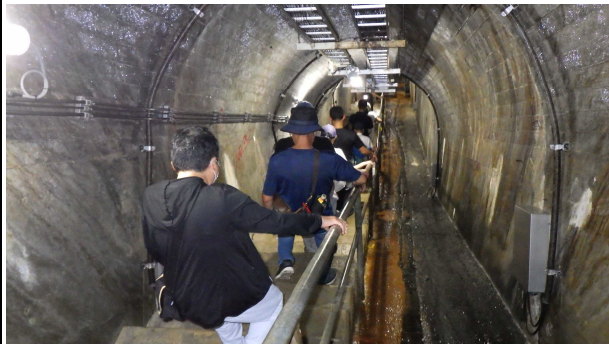
監査廊内の様子
