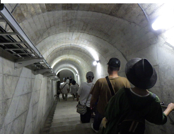
監査廊内の様子
