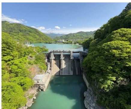
高遠ダム・高遠さくら発電所
