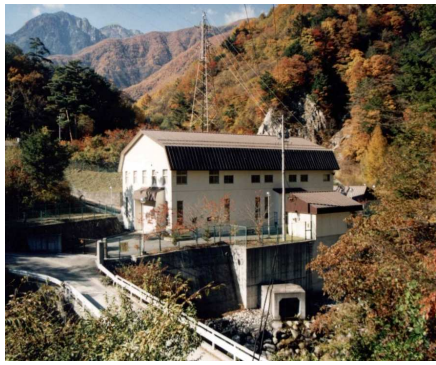
与田切発電所
