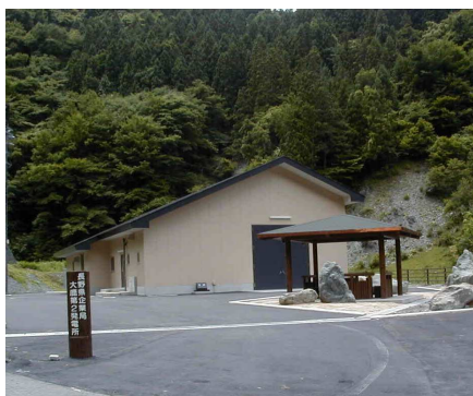
大鹿第2発電所
