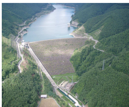
味噌川ダム・奥木曽発電所
