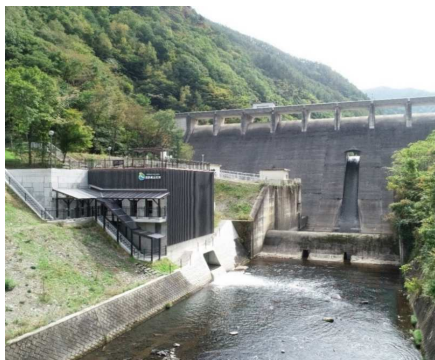
横川ダム・横川蛇石発電所
