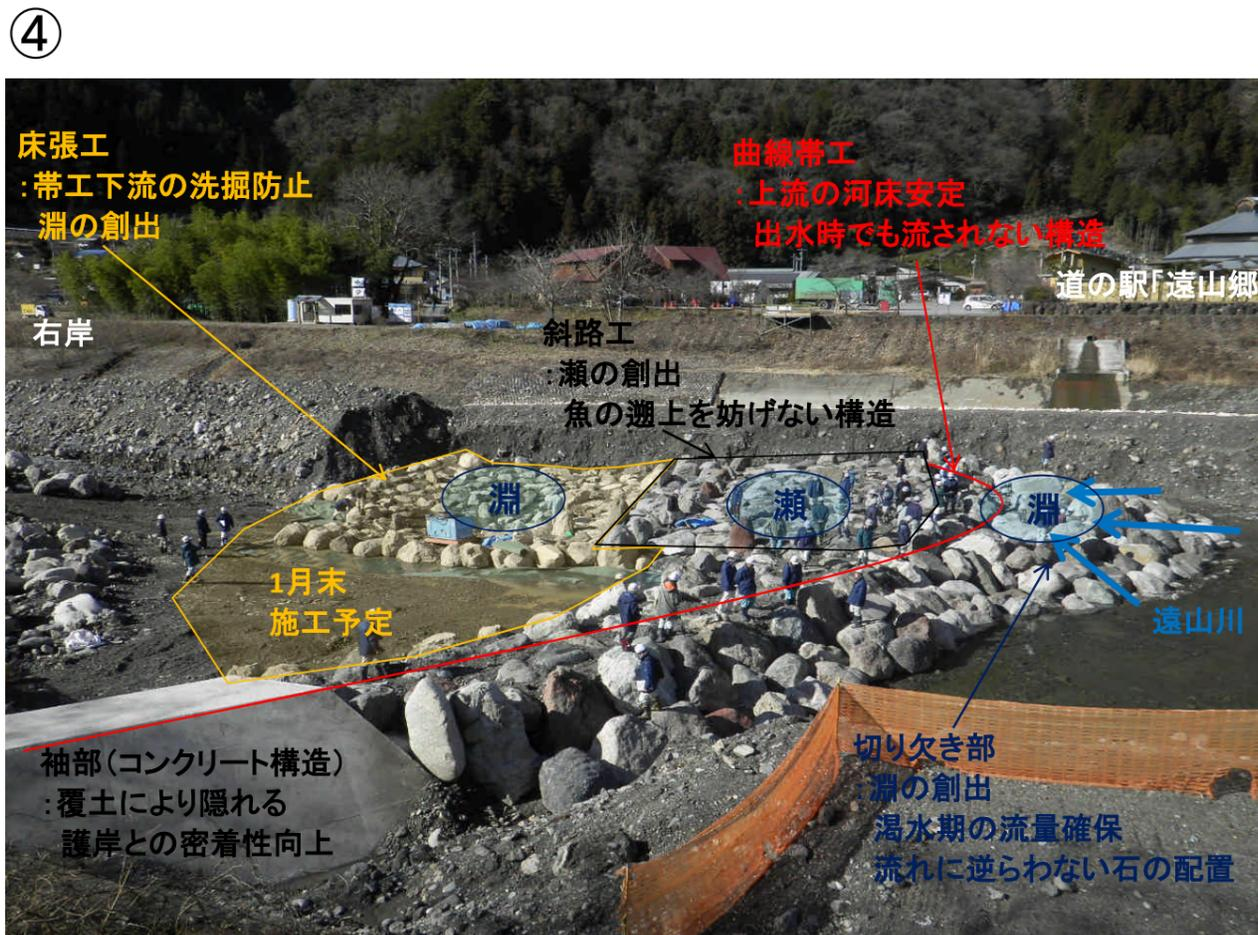
④ 上流左岸側から右岸側を望む(帯工の構造解説)
