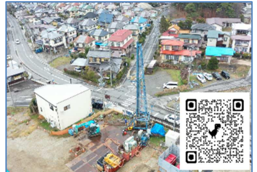
【安定した用水を確保するため取水井戸を改修：動画】
