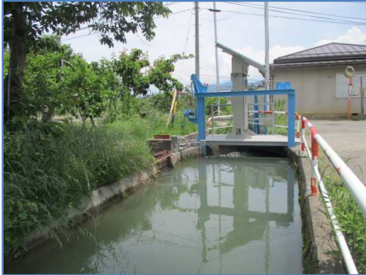
【豪雨時に自動で開門する水門を設置】
