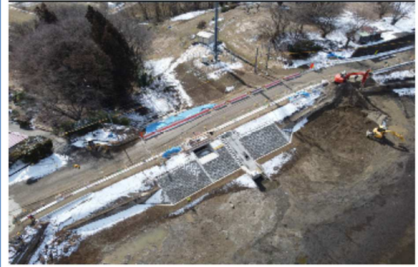
【ため池の防災工事が完了し安全性が向上】
