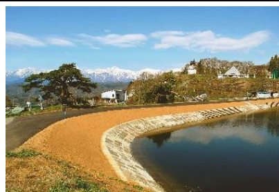
【安全に整備されたため池】
