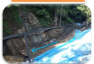
崩壊した土砂や倒木の撤去、水廻しの 復旧を行い、床掘を再開し始めました
