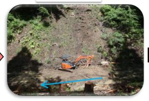
上流から沢の水を排水管で下流まで誘導して (水廻し)、作業するところに水が流れないように してから、伐採から作業を進めていきます
