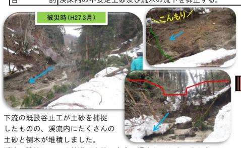
渓流に隣接している林道は土砂で完全に埋塞してしまいました 下流には人家があったため、土石流センサーを設置しました
