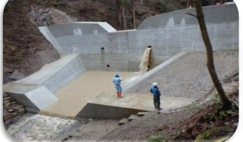
型枠も外されて、本流に水が流され、無事に本堤と 副堤が完成しました! 残る工程は、周辺の土工と間詰工のみです
