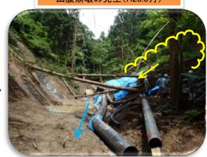
床掘作業中だった8月、降雨により左岸側の 斜面から山腹崩壊が発生してしまいました…!
