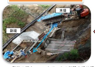
型枠の組立、コンクリートの打設を繰り返し、 構造物を仕上げていきます。今回は本堤の谷止工 のほか、流量が多いことから、谷止工の根元が 洗掘されないよう、前方に「副堤」を施工します
