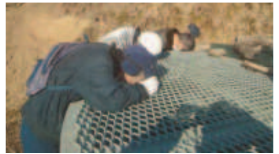
【地すべり防止施設点検状況】
