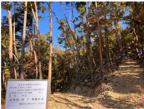
坂城町御所沢地区 着手前
