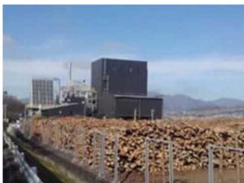
木質バイオマス発電施設【東御市】
