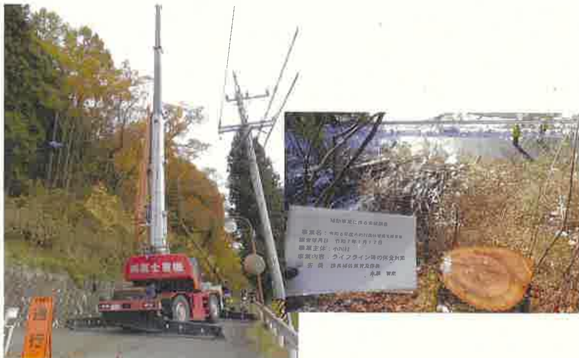
実 施 後（柏土） 作業中～伐採後
