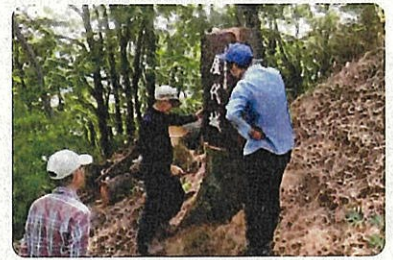
看板の設置作業
