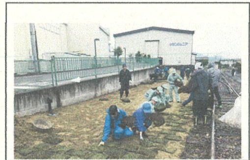
【公園整備 (芝張り)】
