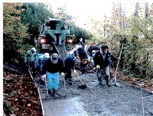
【舗装工事風景】
