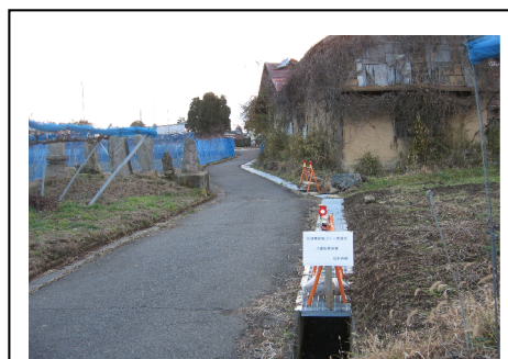
【水路改修事業】
