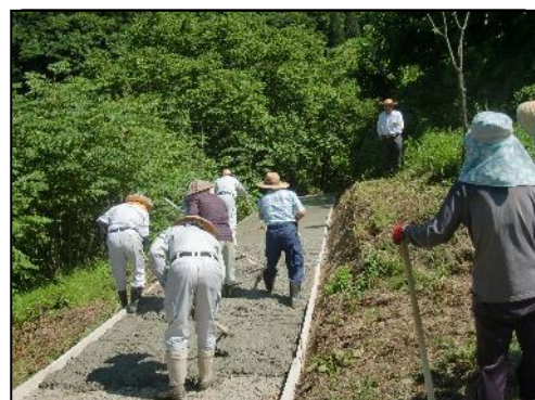
【上和地区 (日影) での作業】
