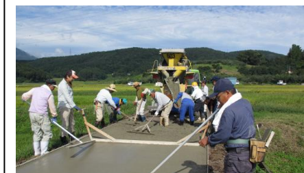
【協働で行う生コン打設作業】
