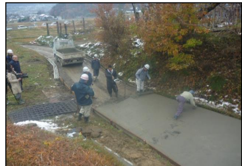
【舗装工事風景】
