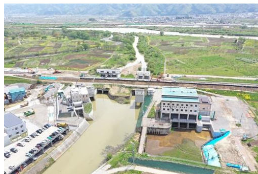
浅川排水機場
